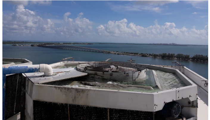
Cooling Towers After Hurricane Irma Torres de enfriamiento después del huracán Irma .....
