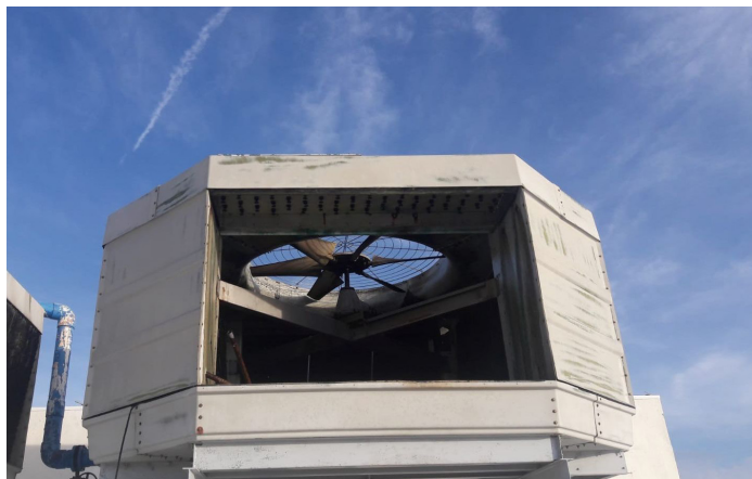
Cooling Towers After Hurricane Irma Torres de enfriamiento después del huracán Irma
