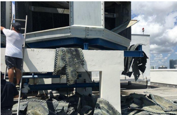
Cooling Towers After Hurricane Irma Torres de enfriamiento después del huracán Irma
